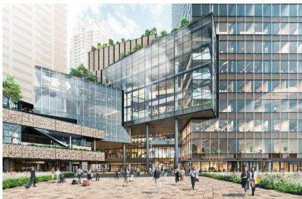
施設の外観（北館）
