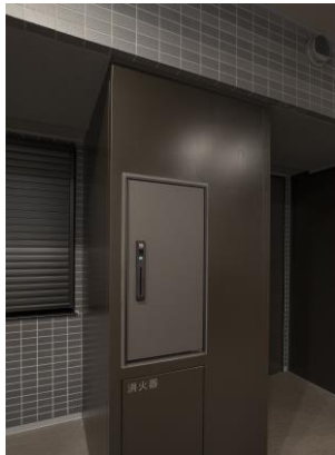
宅配ボックス
