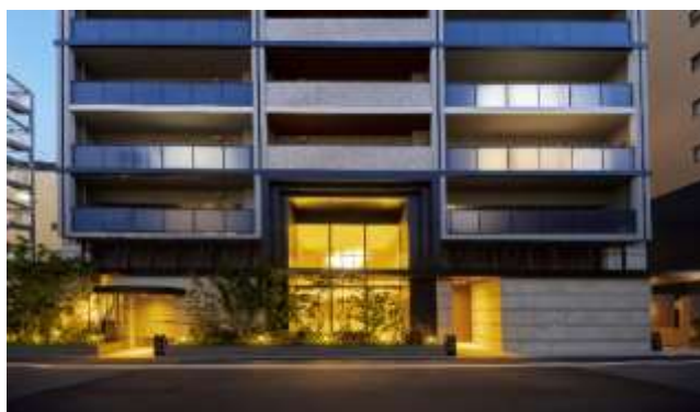
参道側から見るラウンジ
