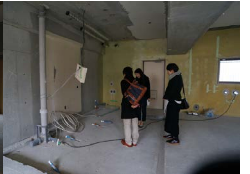
解体後専有部：スケルトン状態まで解体し、購入検討者にもご確認いただいた
