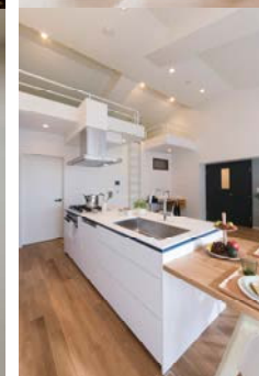
リノベーション後専有部(603号室)：解体後にあらわれた勾配天井の懐を活用し、ロフト付の吹抜空間(最高高さ約4m)を設けた
