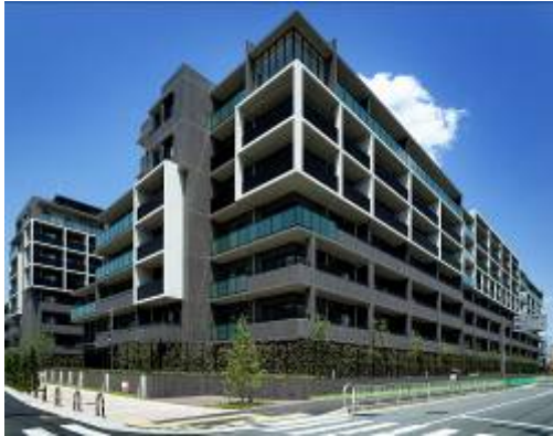
外周道路に接道する南西からの景観
